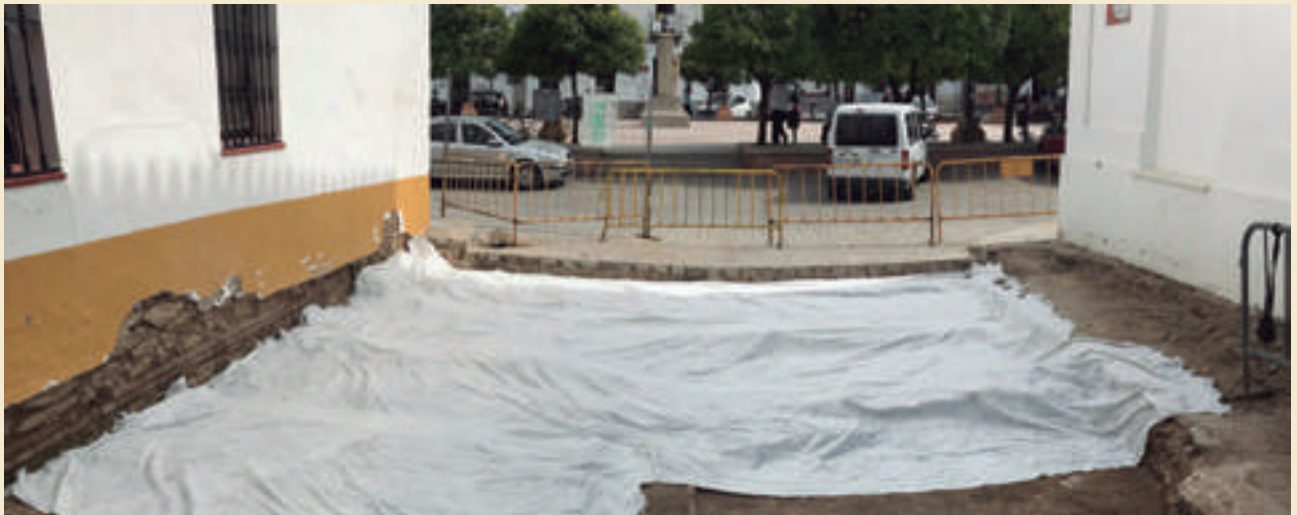
Figura 21. Protección con lámina de geotextil del sector norte en el que se localiza la muralla y otros restos murarios
