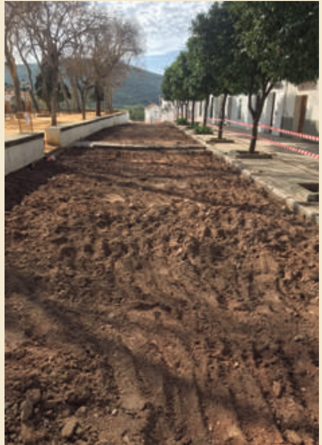
Figura 1. Proceso de retirada de pavimento de granito de la calzada
