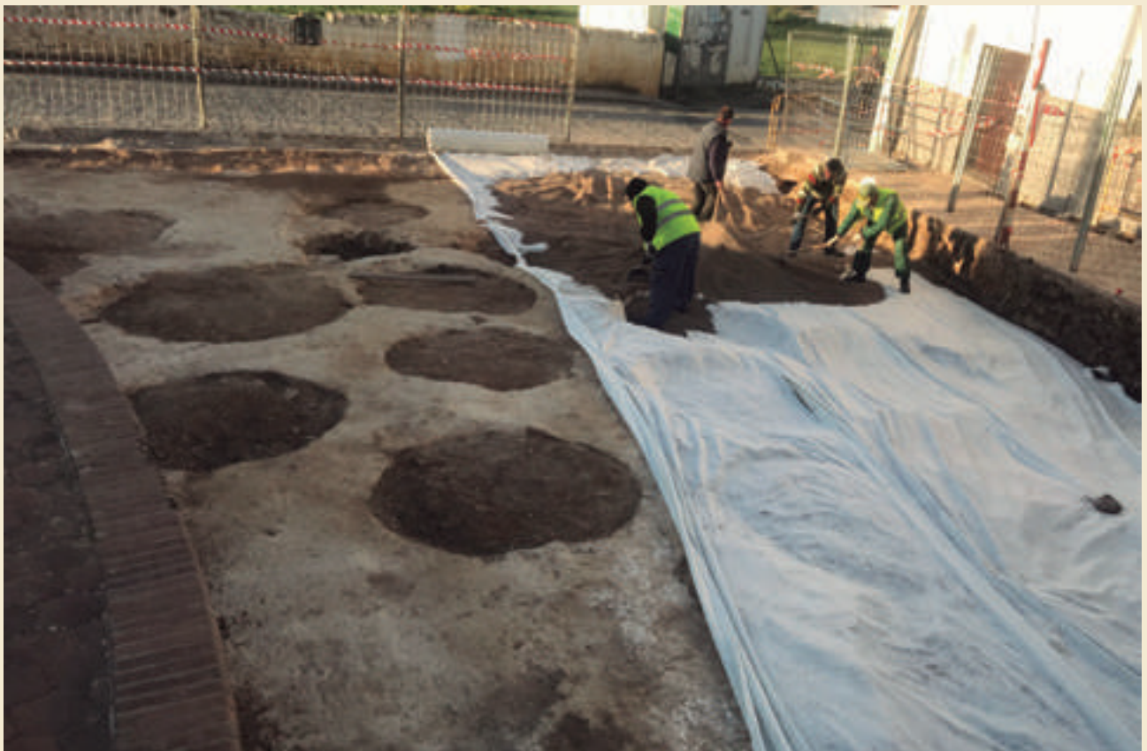
Figura 22. Proceso de colocación de geotextil y capa de áridos protegiendo el sector sur, en el que se localizan fosas posiblemente asociadas a balsas de curtidurías
