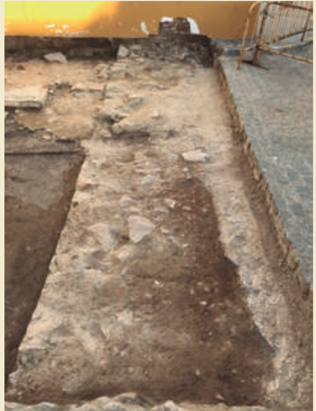
Figura 18. Vista desde el extremo este de los restos conservados de la muralla almohade, observándose a la derecha la destrucción de la cara interior con la losa de hormigón que sirve de base al pavimento de adoquines de la plaza
