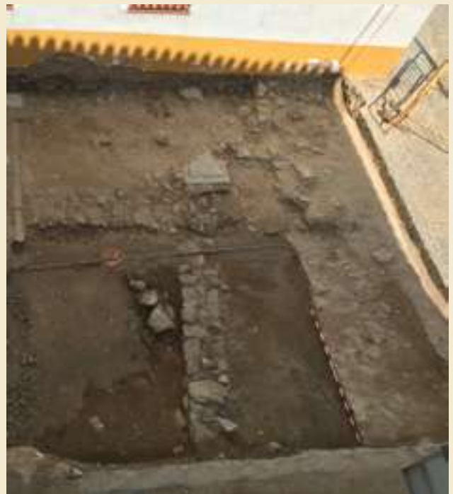
Figura 20. Vista cenital de la muralla y los muros de mampostería palaciegos, afectados por instalaciones de saneamiento y abastecimiento
