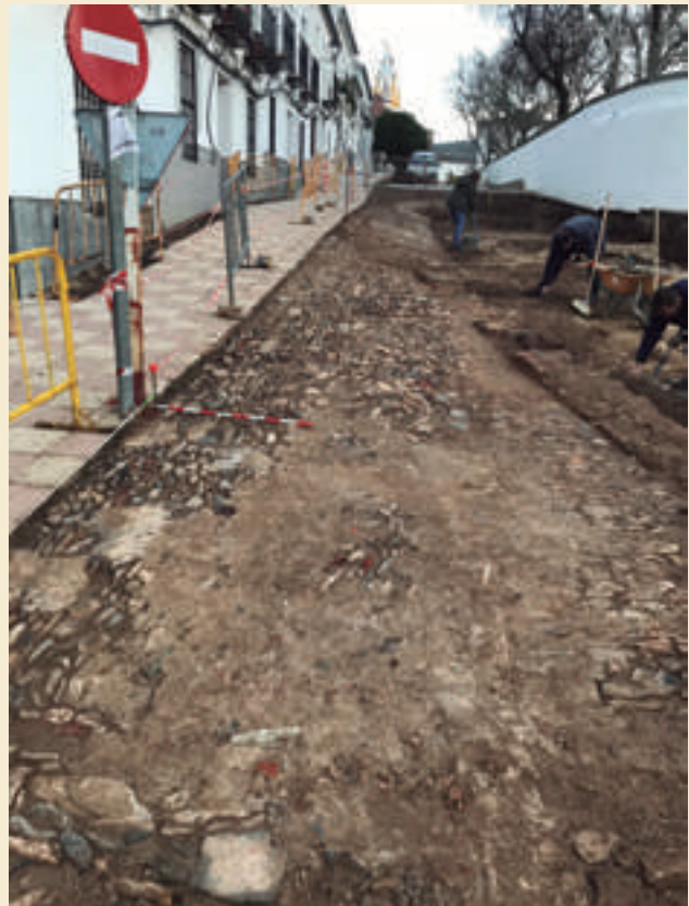
Figuras 3 y 4. Trabajos de excavación manual y limpieza de los restos de empedrado documentados frente a las fachadas de las casas nº32 a la 38
