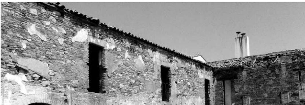
Fig.40. Estado imagen de la fachada exterior del claustro. En la parte superior derecha de la imagen intuimos el sistema constructivo utilizado en las cubiertas de las galerías superiores del claustro. Fuente: Ignacio Gómez.
