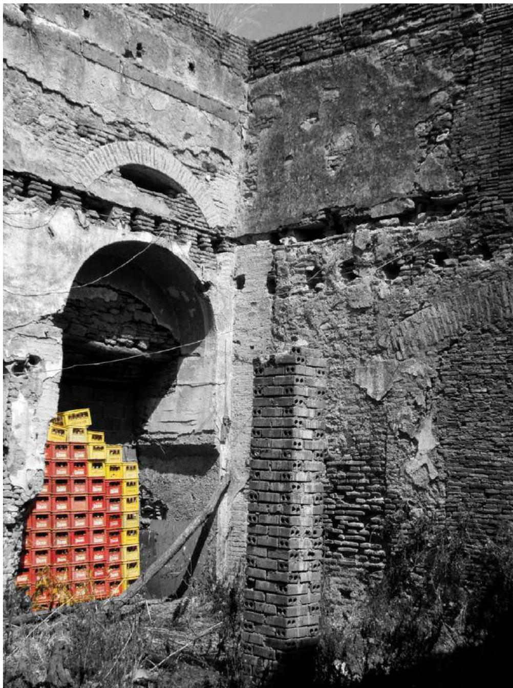
Fig. 111. Fotografía del interior de la nave de la antigua iglesia reutilizada a mediados del siglo XX para la fabricación de gaseosas y taller de bicicletas. En ella apreciamos un pilar de fábrica en el que se apoyaba una cubierta improvisada en dicho espacio. Fuente: Archivo fotográfico de Ignacio Gómez. 2011.
