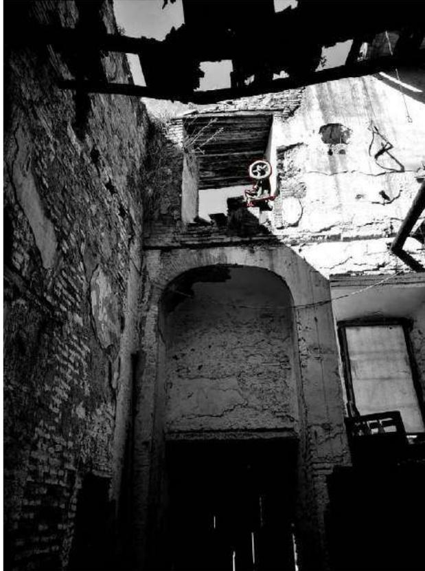
Fig. 76. Imagen desde el coro bajo destacando el hueco realizado en fachada hacia la calle Santa Clara que posteriormente será utilizado para colocar una polea y elevar el cargamento de grano al segundo piso correspondiente con la zona de almacenaje.
