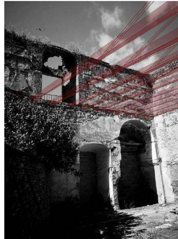
Fig. 89. Imagen interior de la nave de la antigua iglesia. Dibujado en ella el nuevo sistema de cubierta y de forjado para crear la primera planta de la fábrica de harina. Fuente: Elaboración propia.
