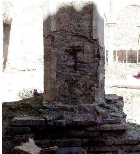
Fig.32. Detalle basamento del pilar votivo elaborado con fábrica de ladrillo tejar y revestimiento de mortero de cal. Fuente: Elaboración propia.
