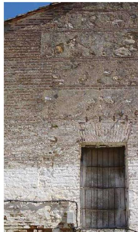
Fig.41. Detalle de la fachada exterior correspondiente a la Calle Santa Clara. En ella se aprecia con claridad el sistema de muro tapial para estas fachadas exteriores. Cabe destacar que este muro tapial estaría revestido con mortero de cal, ocultando el sistema constructivo. Fuente: Elaboración propia.
