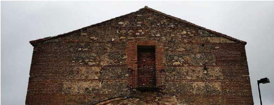
Fig. 96. Fotografía de la fachada trasera de la iglesia correspondiente con la cabecera de la nave donde en planta superior se realiza una abertura con un pequeño voladizo. Fuente: Elaboración Propia.
