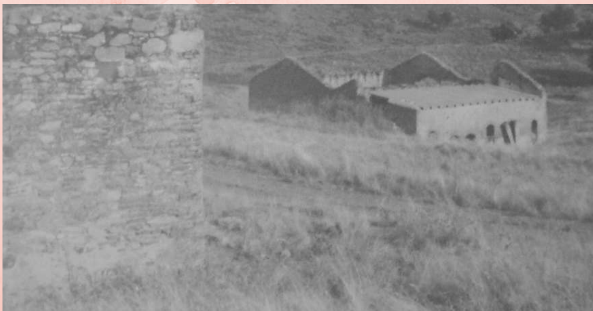
Resto de las minas de Pozo Rico en el año 1978
