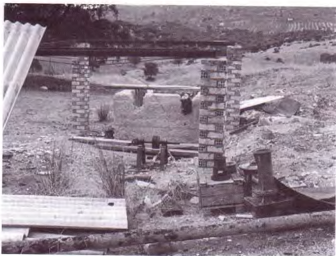
Brocal del pozo más importante, seguramente Pozo Rico.
