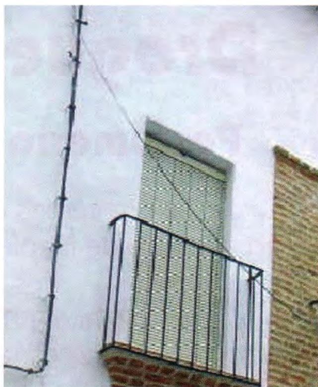
Restauración de fachada en calle Santiago, 35 (Llerena)
