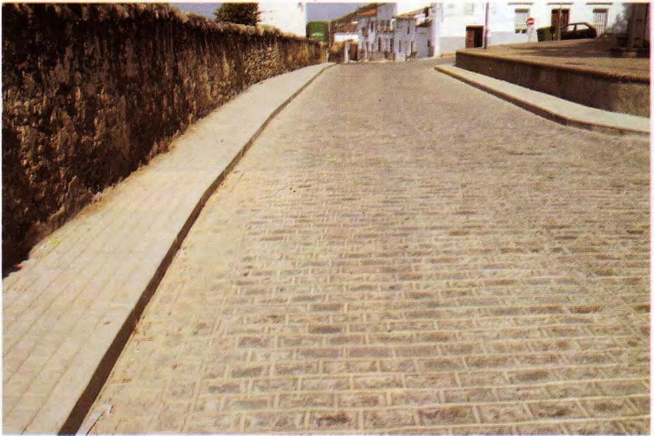
OBRA AVDA. DE LA CONSTITUCIÓN
