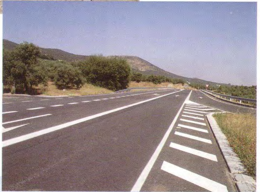
Mejora de los accesos a Guadalcanal, por la carretera que nos une con Extremadura.
