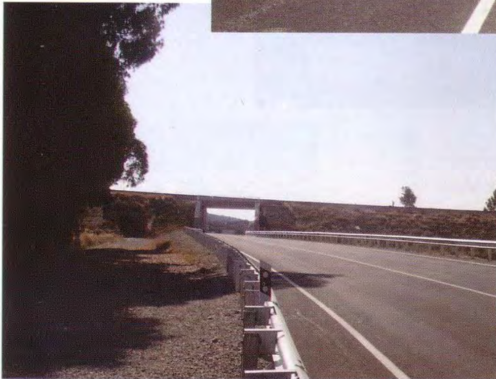
Nuevo puente de San Benito, en la carretera de Alanís.
