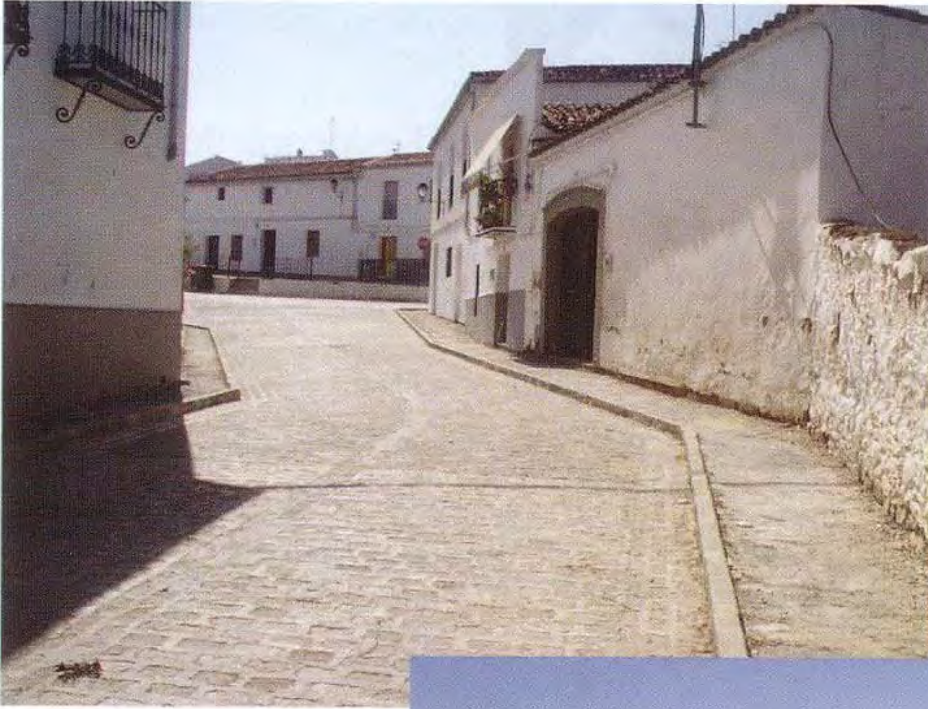
Calle de San Francisco, a punto de finalizar su reparación.
