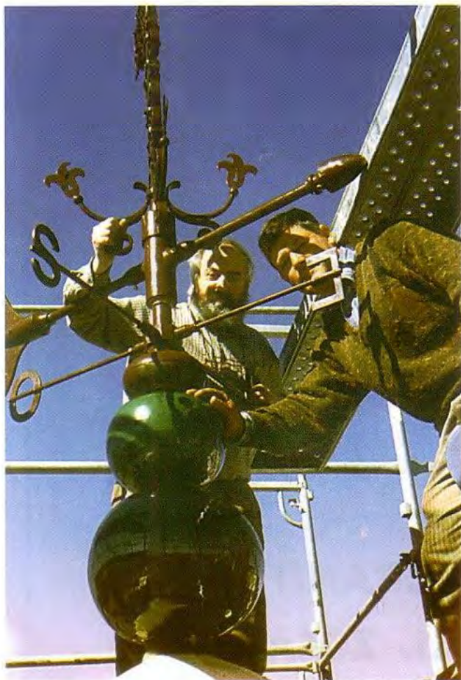
Colocación en su emplazamiento definitivo
