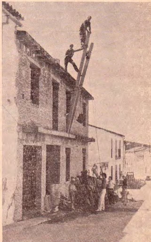
En construcción. . . Casa del Médico
