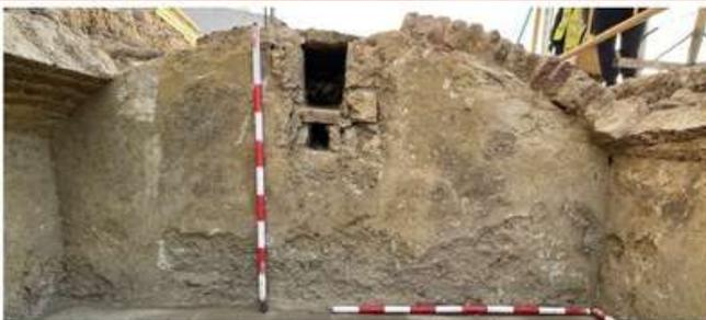
Muro de cierre este UE 21. Observamos en la coronación el perfil de apoyo de la bóveda de cañón rebajado que cubriría el depósito. En el centro y parte superior se sitúan dos vanos para la entrada de agua. El inferior más reducido es el original y recibiría el agua de una pila de lavado de ropa situada al este del depósito. El vano superior horada la fábrica del muro y se asocia al registro UE 21, situado en la cara externa del muro, anulando la pila de agua de lavado.
