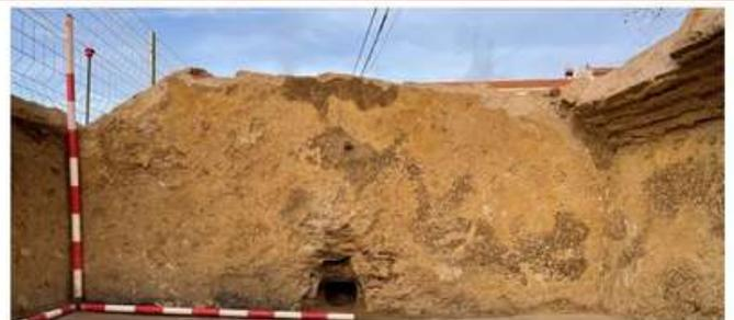
Muro de cierre oeste UE 17. La coronación del muro está parcialmente destruida, apreciándose, no obstante, parte del apoyo de la bóveda de cañón rebajado que cubriría el depósito. En el centro y parte inferior se sitúa el vano de salida de aguas, conectado con la atarjea UE 15.
